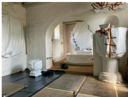
Alle bænke har været taget ud af kirken i forbindelse med restaureringen og præste- og altertavle, døbefont og prædikestol har været indpakket.
